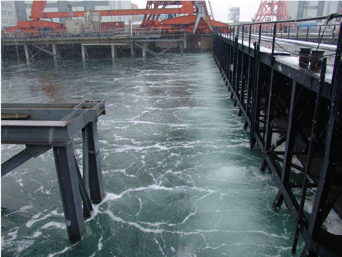
HDW Kiel – Druckluft-Ölsperre zur Absicherung eines Trockendocks
