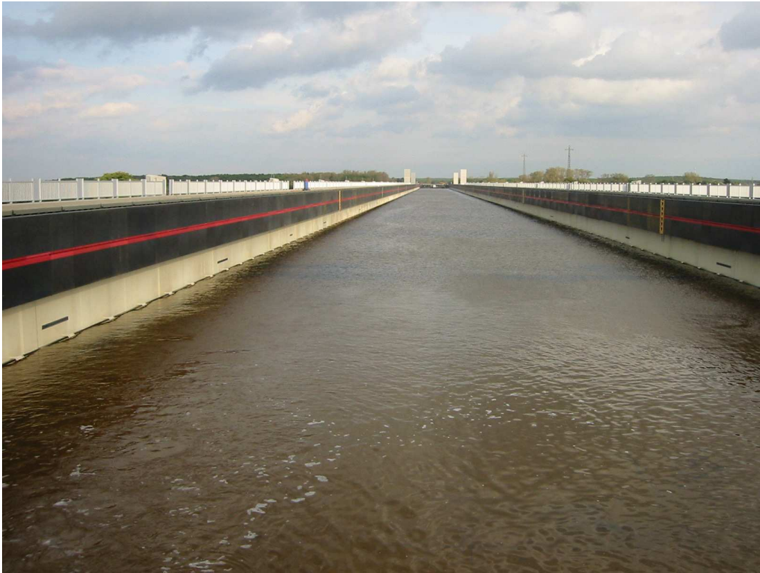
Eisfreihaltesystem für Kanalbrücke Magdeburg
