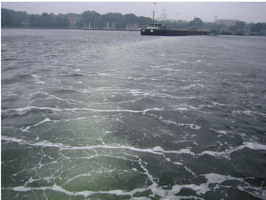
Druckluft-Ölsperre zur Absicherung der Hafeneinfahrt Kiel-Tirpitzhafen
