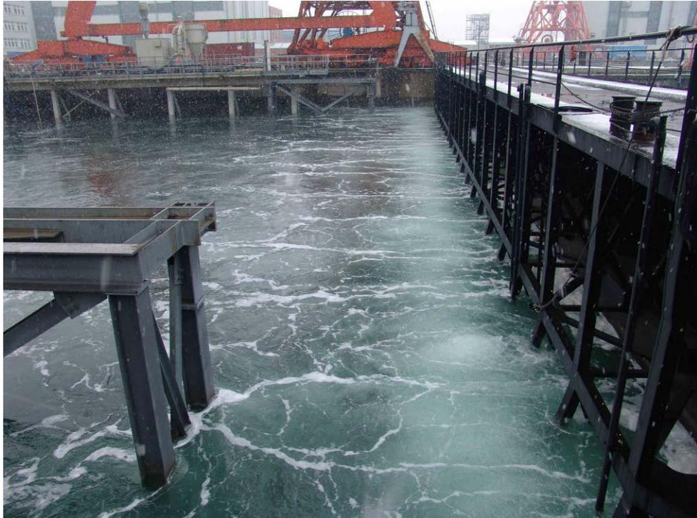
HDW Kiel – Druckluft-Ölsperrre zur Absicherung eines Trockendocks
